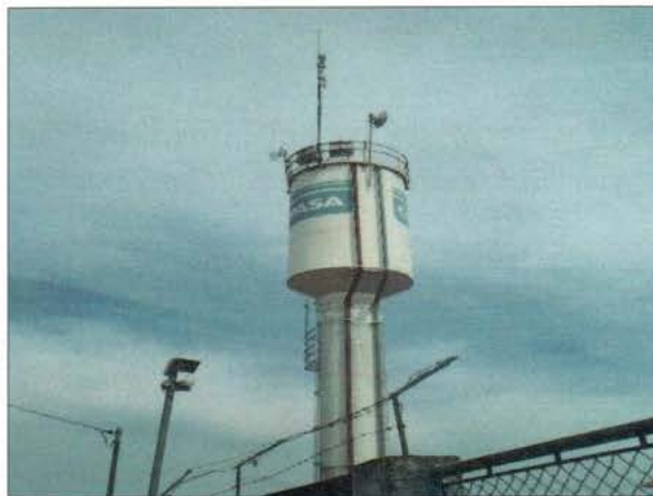
FIGURA 13 - VISTA DO RESERVATÓRIO R2 (FONTE: ACERVO PESSOAL, 2014).
