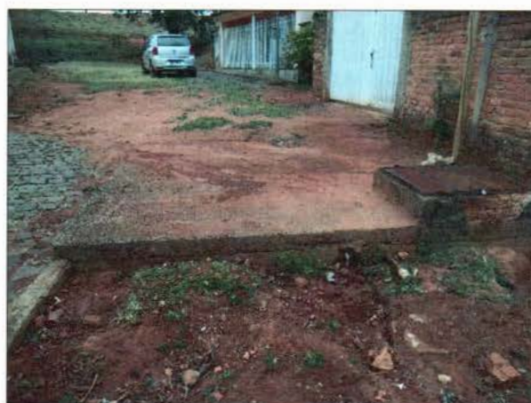
FIGURA 35 - RESERVATÓRIO DE SÃO JOSÉ DOS MERCÊS (FONTE: ACERVO PESSOAL, 2014).
