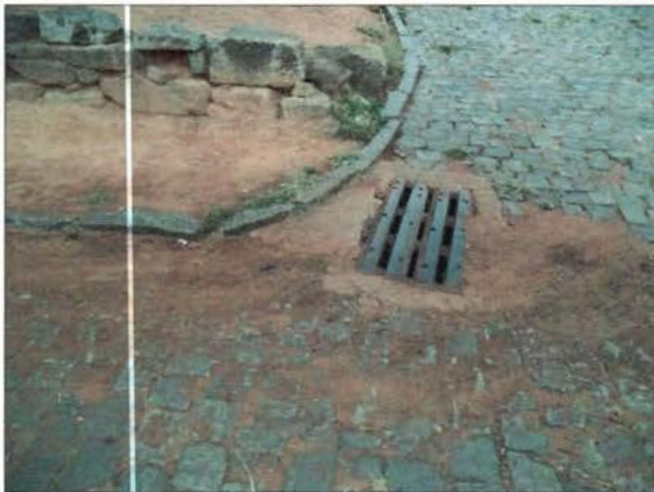
FIGURA 81 – BOCA DE LOBO NA LOCALIDADE DE SÃO JOSÉ DAS MERCÊS (FONTE: ACERVO PESSOAL, 2014).
