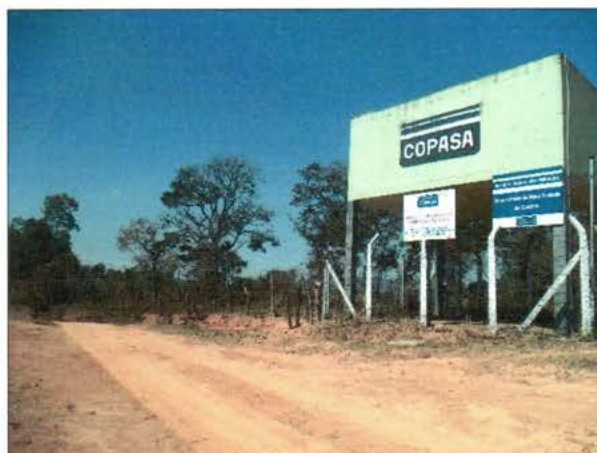
FIGURA 27 - RESERVATÓRIO R3 - VISTA 2 (FONTE: ACERVO PESSOAL, 2014).
