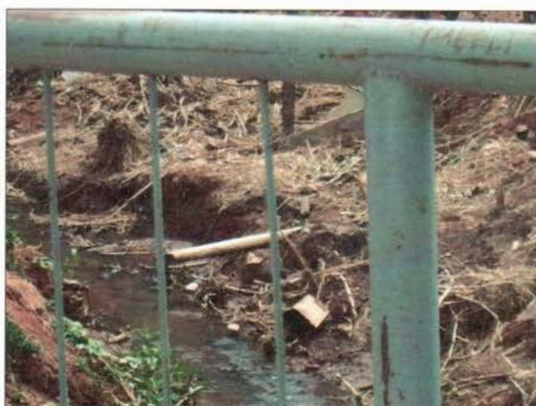
FIGURA 55 - LANÇAMENTO DE ESGOTO NO CÓRREGO BRUMADO (FONTE: ACERVO PESSOAL, 2014).
