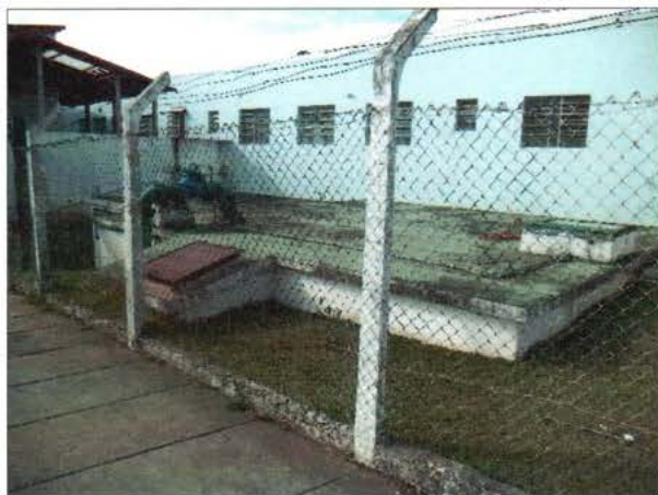
FIGURA 12 - VISTA DO RESERVATÓRIO R1 (FONTE: ACERVO PESSOAL, 2014).
