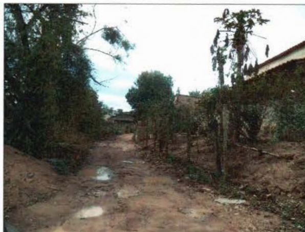
FIGURA 96 - PUNTO DE ALAGAMENTO NO DISTRITO SEDE - VISTA 2 (FONTE: ACERVO PESSOAL, 2014).
