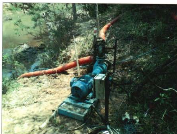
FIGURA 8 - CAPTAÇÃO NO RIO BRUMADO - VISTA 2 (FONTE: ACERVO PESSOAL, 2014).
