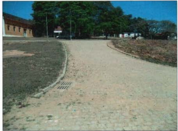
FIGURA 80 – BOCA DE LÓBO NO DISTRITO DE SERRA DO CAMAPUÃ (FONTE: ACERVO PESSOAL, 2014).
