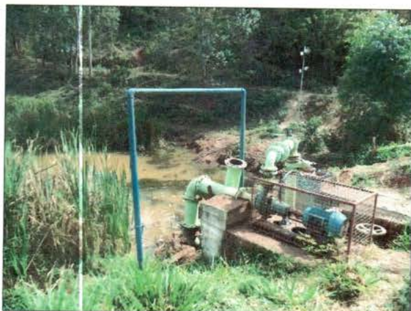
FIGURA 5 - CAPTAÇÃO NO CÓRREGO DO LUCA -VISTA 1 (FONTE: ACERVO PESSOAL, 2014).
