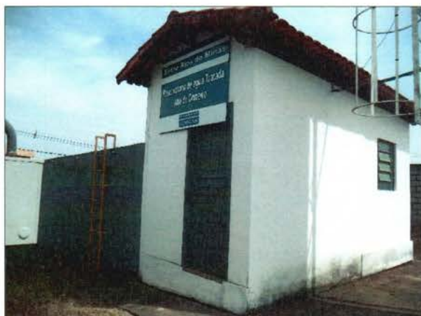
FIGURA 14 - VISTA DO RESERVATÓRIO R3 (FONTE: ACERVO PESSOAL, 2014).
