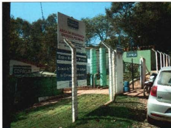
FIGURA 23 - ETA MORRO GRANDE - VISTA 2 (FONTE: ACERVO PESSOAL, 2014).
