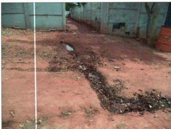
FIGURA 52 - ESGOTO A CÉU ABERTO - VISTA 1 (FONTE: ACERVO PESSOAL, 2014).
