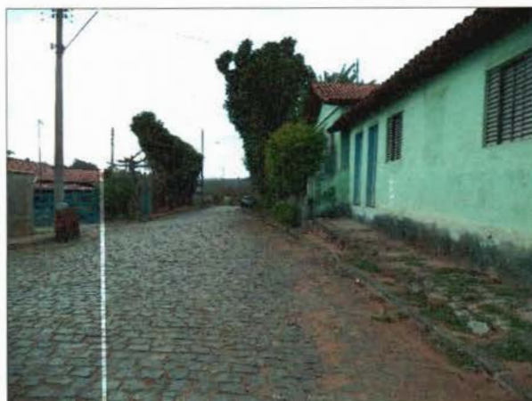
FIGURA 89 - VIA DESPROVIDA DE EQUIPAMENTOS DE DRENAGEM NA LOCALIDADE DE SÃO JOSÉ DAS MERCÊS (FONTE: ACERVO PESSOAL, 2014).
