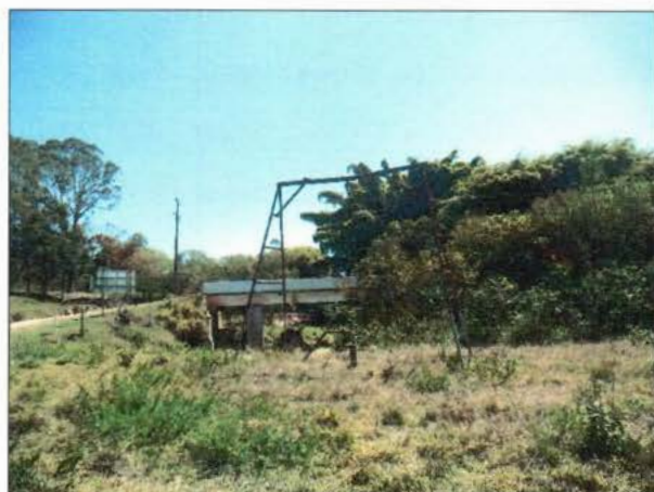
FIGURA 17 - POÇO ARTESIANO - DISTRITO DE SERRA DO CAMAPUÃ (FONTE: ACERVO PESSOAL, 2014).
