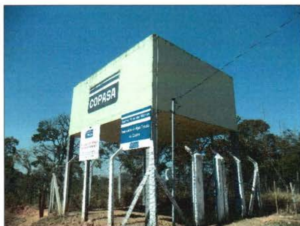
FIGURA 26 - RESERVATÓRIOS R3 - VISTA 1 (FONTE: ACERVO PESSOAL, 2014).
