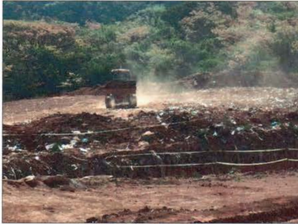
FIGURA 75 - ATERRO CONTROLADO - VISTA 1 (FONTE: ACERVO PESSOAL, 2014).
