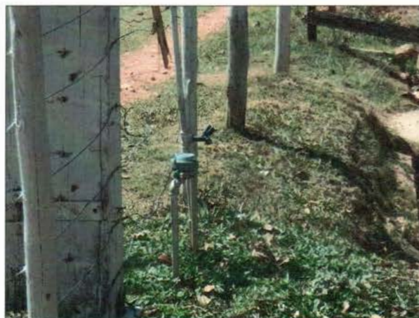
FIGURA 49 - HIDRÔMETROS NA LOCALIDADE DE SÃO JOSÉ DAS NEVES (FONTE: ACERVO PESSOAL, 2014).
